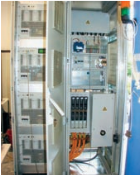
32 kW TopCon Netzgeräte in Parallelbetrieb, flüssiggekühlt Strombereich 0...2000 A
